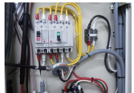
電流プローブでのノイズ確認
