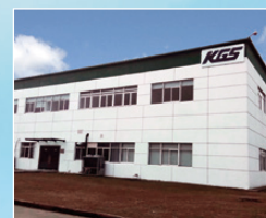
無錫工場 Wuxi (China) factory
